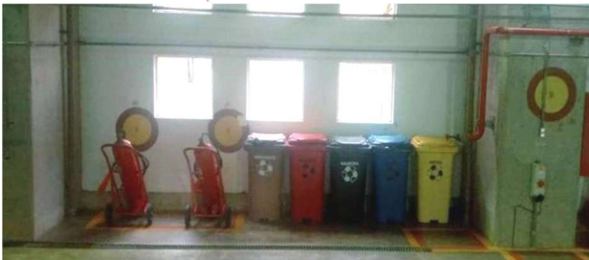
Figura 11 – Acondicionamento temporário de Resíduos Classe II (Casa de Comando) DFESA.
