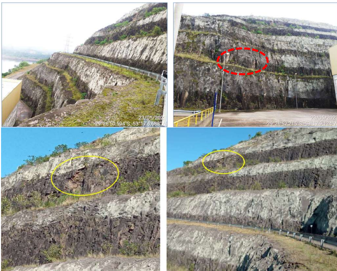
Figura 20 – Taludes basálticos (atrás da casa de força) – maio/2023
