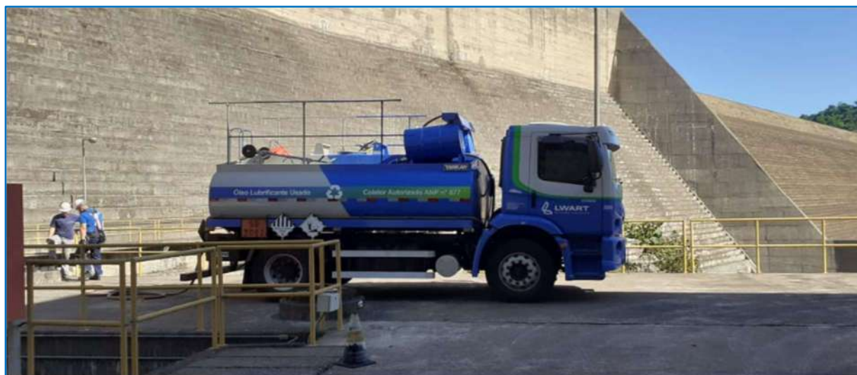
Figura 14 – Limpeza / manutenção Caixa Separadora Água e Óleo (Transformadores Casa de Força UHE Dona Francisca).
