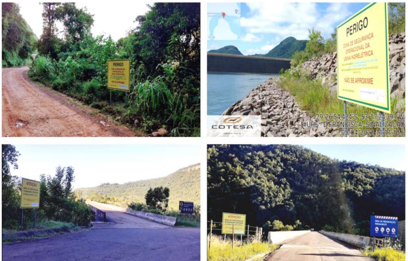
Figura 33 – Sinalização Ambiental na “Zona de Segurança e de Preservação Ambiental” localizadas a jusante do barramento da UHEDF.
