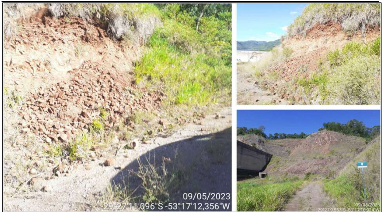
Figura 22 – Ombreira esquerda (maio/2023)
