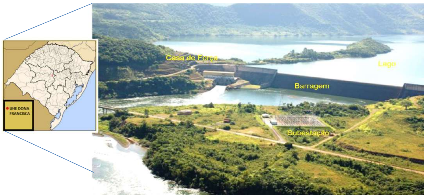
Figura 01 – Localização geral e do barramento/casa de força da UHE Dona Francisca.
