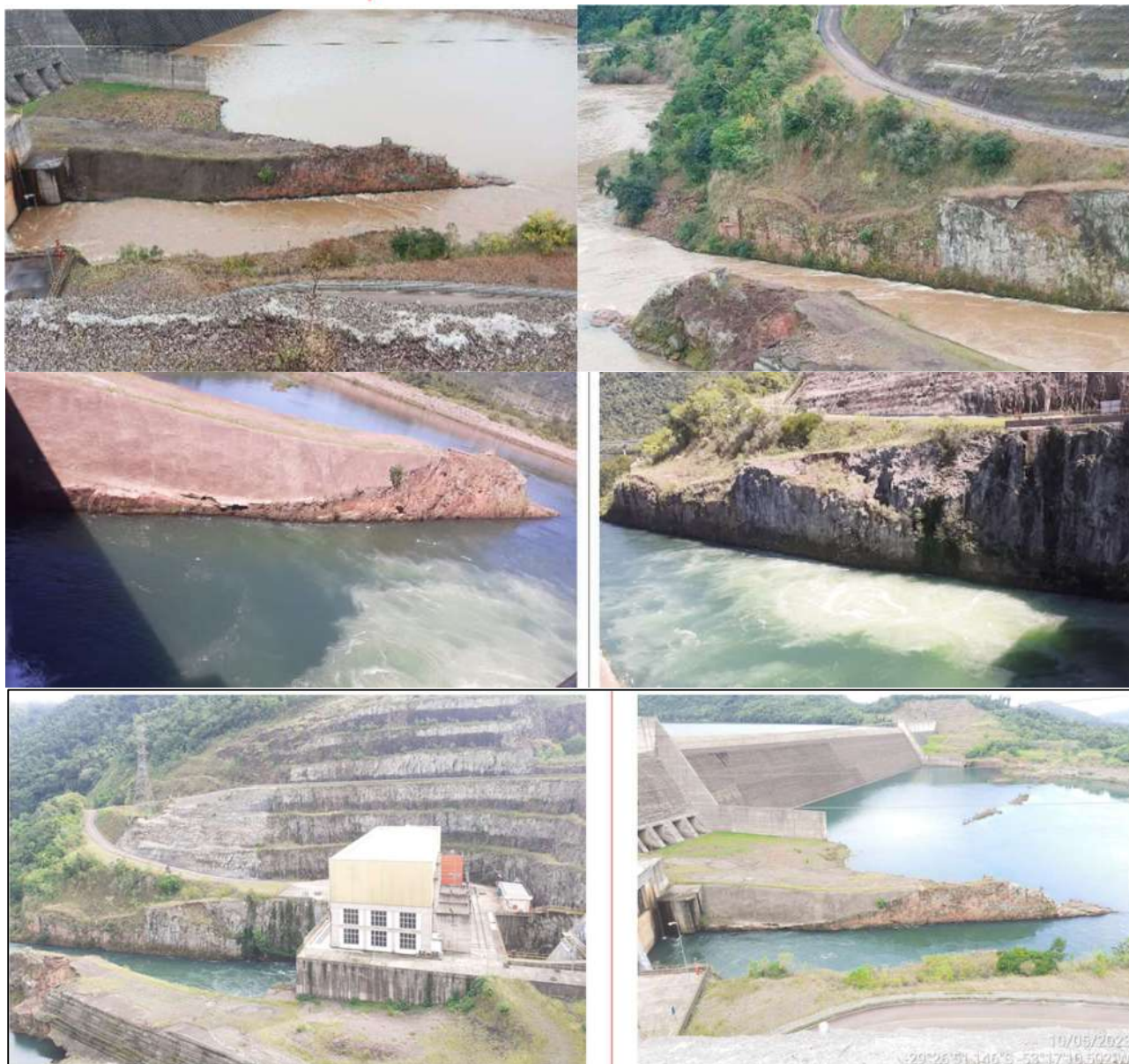
Figura 23 – Canal de fuga em três momentos distintos com ausência de processos erosivos relevantes neste local.
