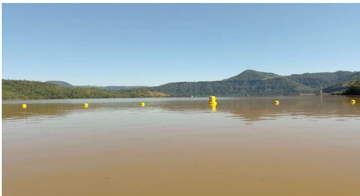
Figura 31 – Sinalização na “Zona de Segurança” da área alagada montante do barramento da UHEDF.
