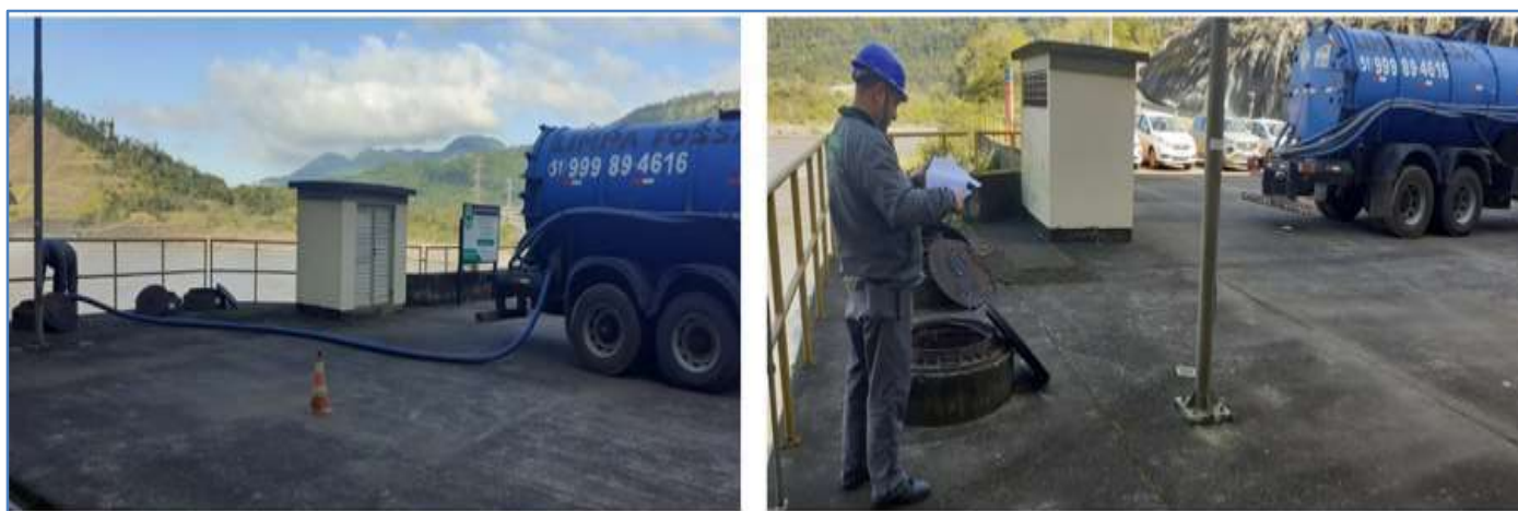
Figura 15 – Retirada / manutenção do Estágio Final da ETE (Casa de Força/UHE Dona Francisca).
