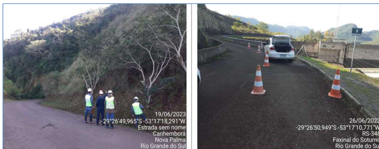
Figura 24 – Monitoramento processos erosivos / inspeção dos Taludes (junho de 2023)
